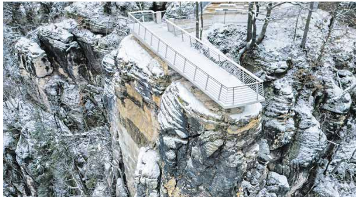
Die neue Aussichtsplattform schwebt auf einer Länge von etwa 10 Metern über dem vorderen Teil des Basteifelsens. Insgesamt ist die Plattform 20 Meter lang und bis zu 3,5 Meter breit.
