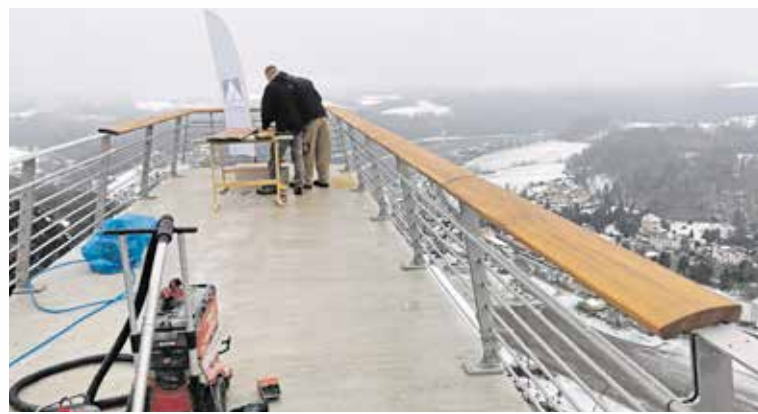
Arbeiten in 200 Metern Höhe über dem Elbtal bei Rathen.
