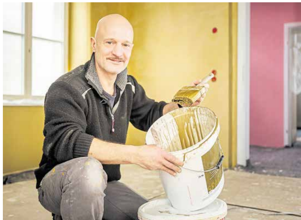
Malermeister und Restaurator Tilo Hasch bei der Arbeit in der Villa – einem Ort für zeitgenössischen Tanz und Darstellende Künste. Peu à peu wird das denkmalgeschützte Bau-Ensemble saniert.
