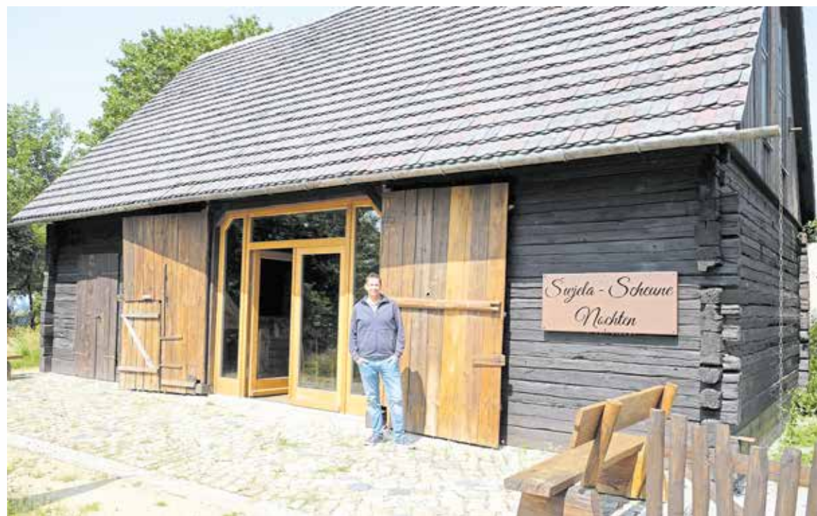
Balken für Balken wurde das 200 Jahre alte Schrotholzbaupark in Nochten aufgearbeitet. Dafür hat sich Ortsvorsteher Mario Weier starkgemacht. Foto: Peggy Michel
